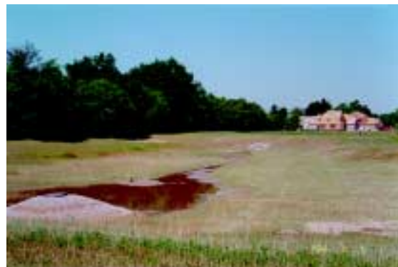
Riser Outlet Pipe
